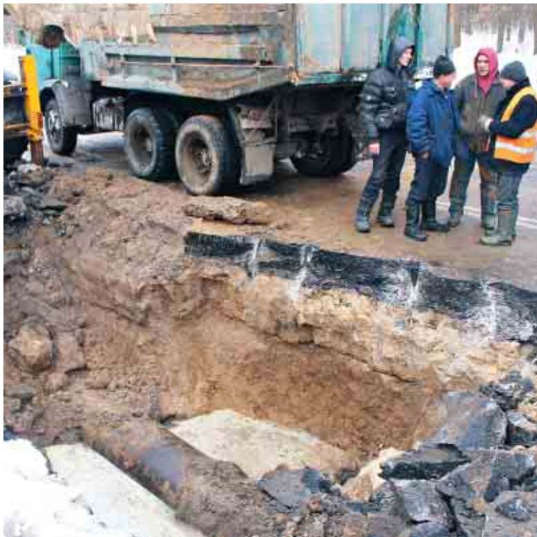
На глибині кількох метрів знаходиться 700-міліметрова труба, яка й прорвала. Комунальники казали, що її ремонтують вже не вперше, бо дуже стара
