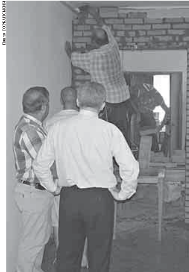
У приміщенні офісу відділу обліку виборців монтують броньовані двері
